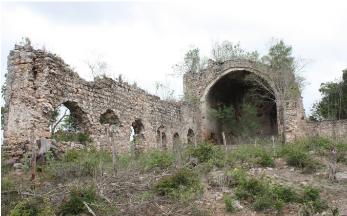
Figura 2. Ruinas de la iglesia de Calotmul. Fotografía tomada por Blanca Escamilla, marzo de 2017.
